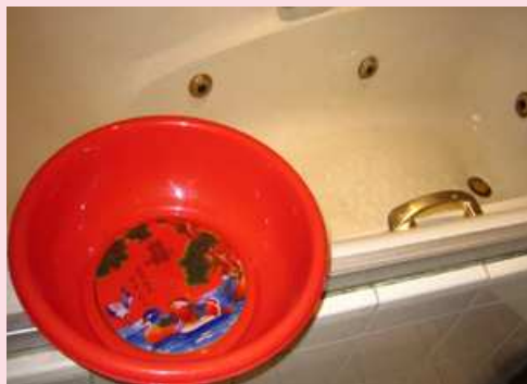
▲浴缸、臉盆無蓄水
