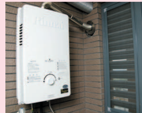
▲熱水器安裝在室外
