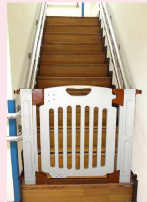
▲在樓梯設置防進入柵欄、加裝防滑條
