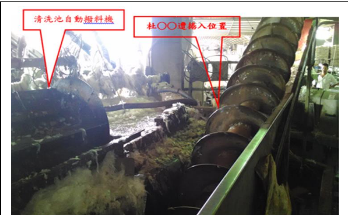
說明二 越南籍勞工杜罹災者捲入之送料螺桿長7公尺、直徑500釐米、馬力3HP。
