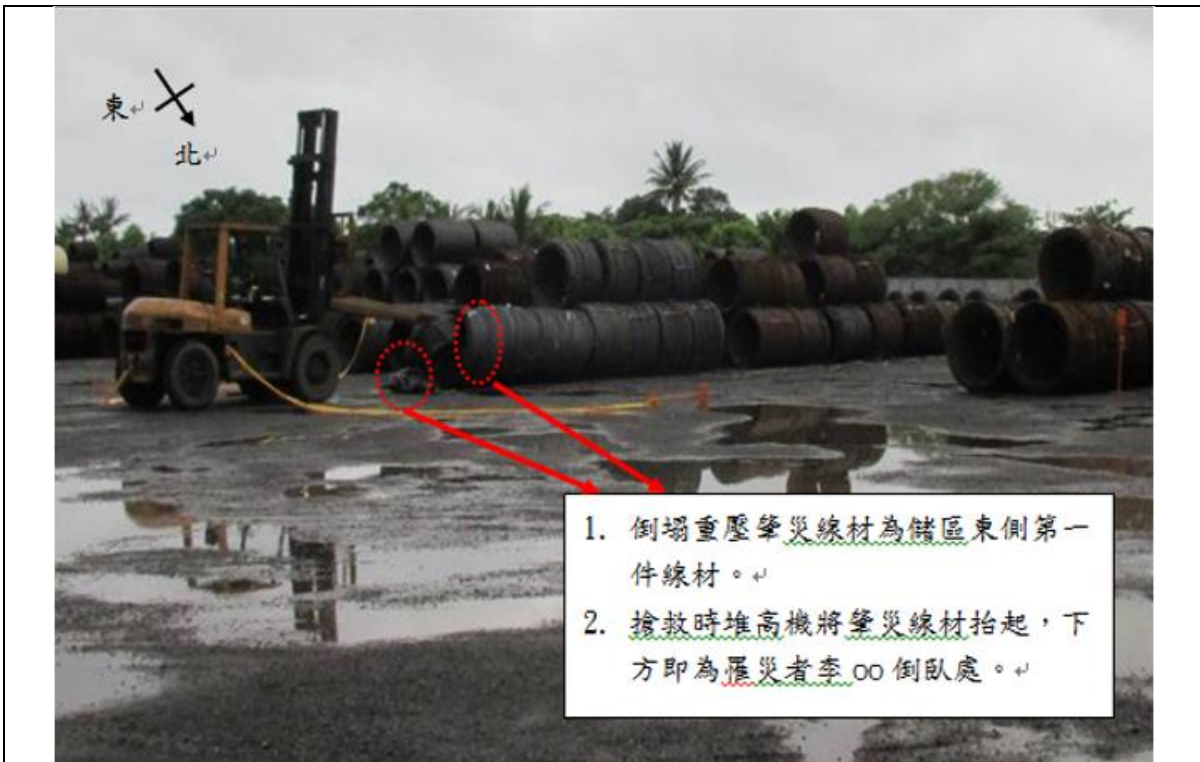
說明一 罹災者李○○遭線材倒塌重壓處現場之概況。
