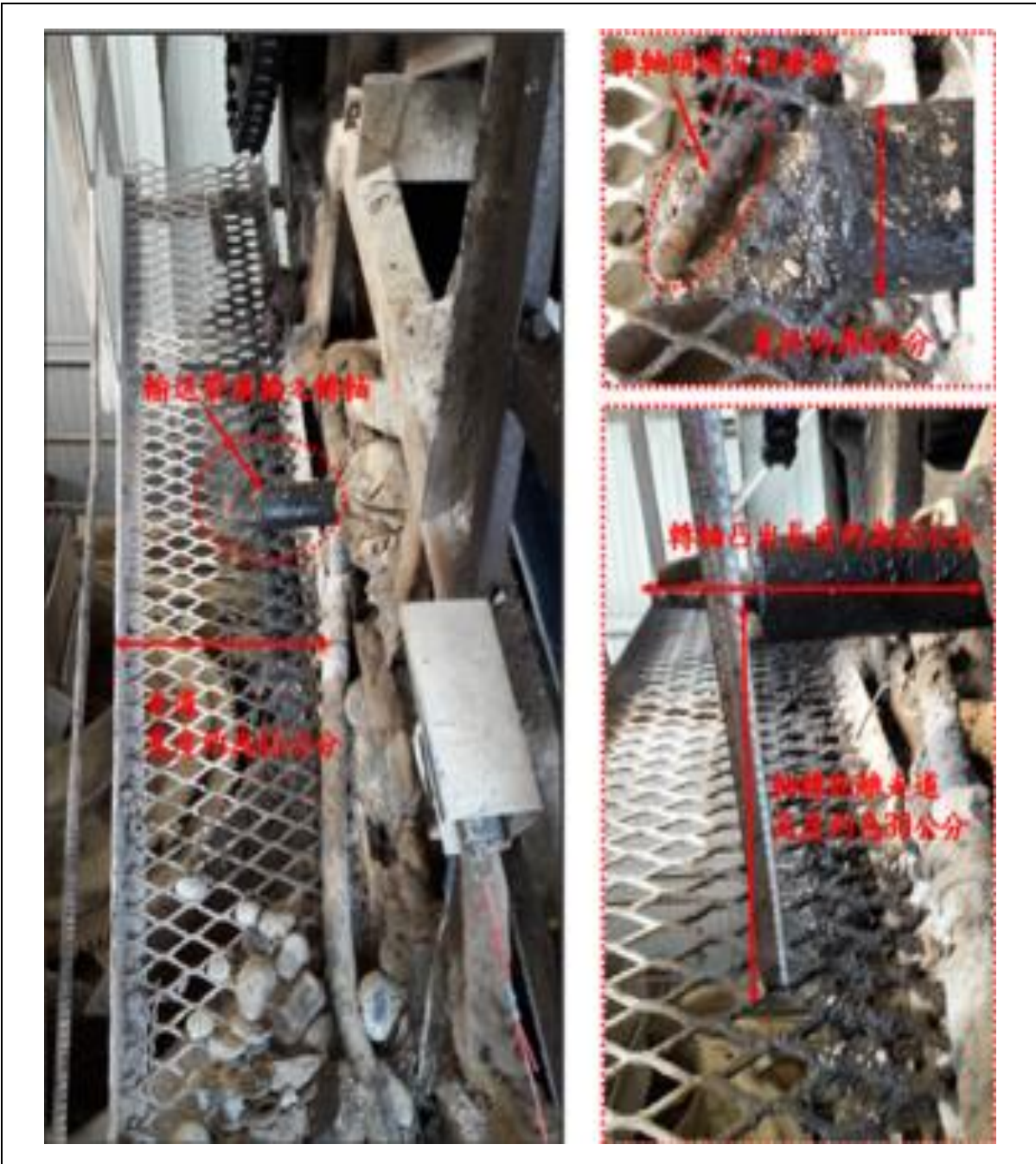
說明一 罹災者被發現時，其趴在碎石機（1號機）之輸送帶旁，其身上雨衣被輸送帶滾輪之轉軸捲入。轉軸頭端有焊接物非為光滑表面，轉軸凸出長度約為25公分、直徑約為6公分，另轉軸距離走道高度約為30公分，走道寬度約為45公分。
