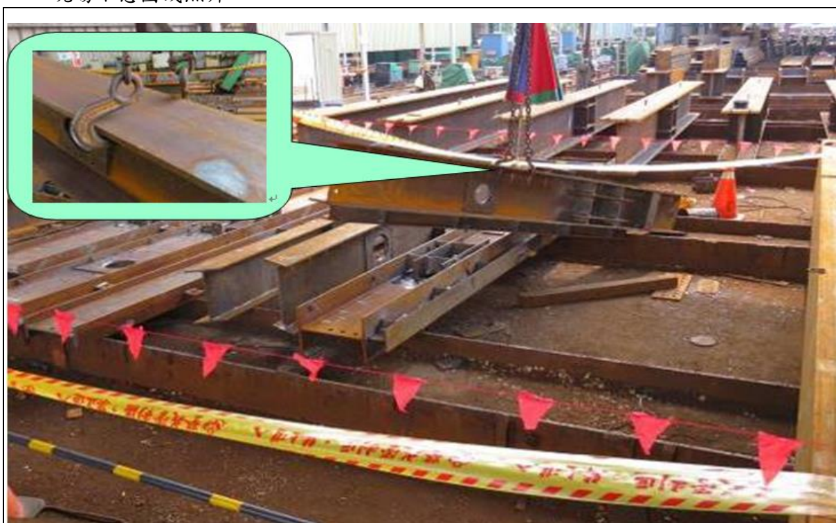
說明一 巨○二次加工區作業場所，肇災處已用警示線圍起。
