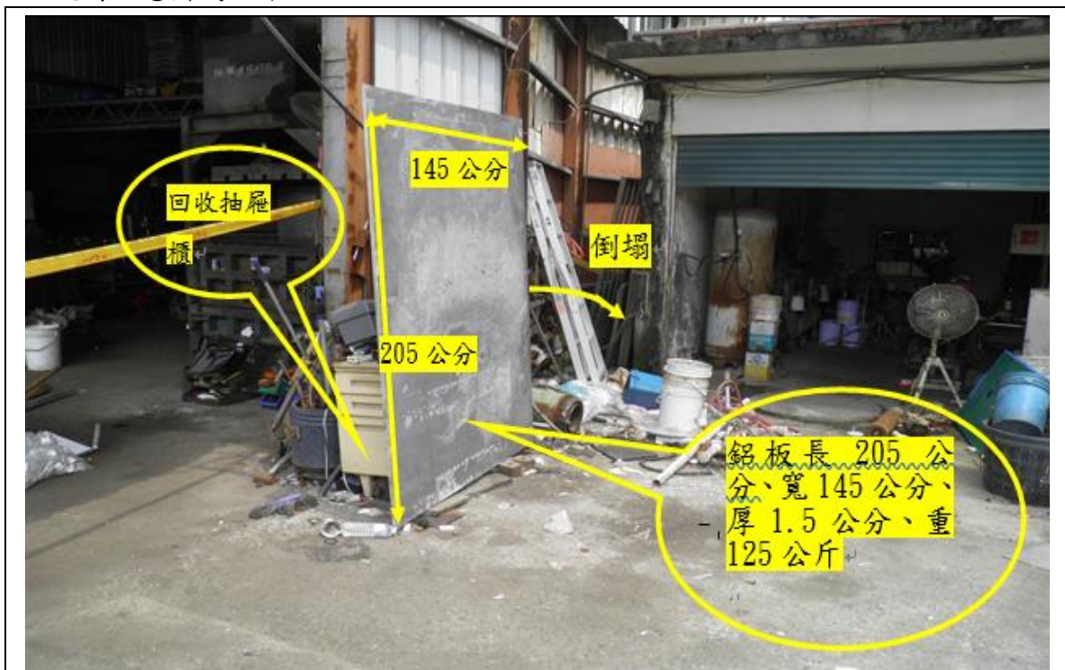
說明一 模擬鋁版倒塌前現場。
