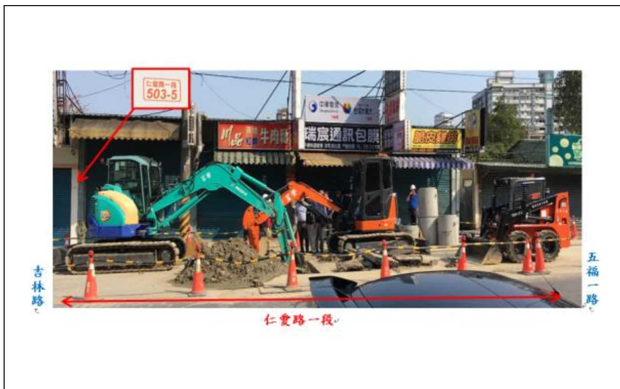
說明二 災害發生時怪手司機陳威鋒駕駛綠色怪手從事管溝開挖作業，橘色怪手則為災害發生後前往救援之怪手。
