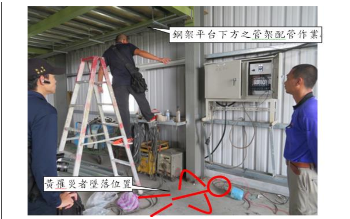
說明三 黃罹災者疑似進行鋼架平台下方之管架配管作業時，一腳踩在合梯第三階（高度 82 公分），另一腳踩在置物平台，不慎墜落，墜落過程身體勾到置物平台邊之掛勾。（照片為○○分局偵查佐現場模擬）
