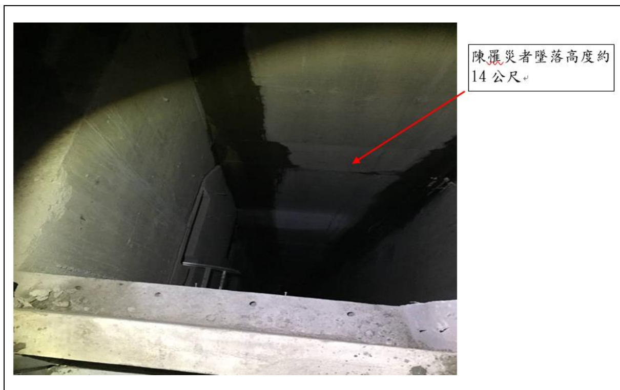
說明二 罹災者墜落開口部分示意圖。
