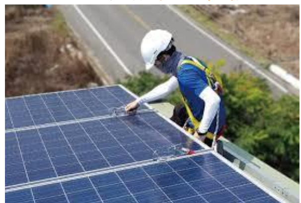
太陽能模組檢修
