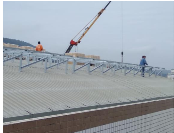
太陽能模組設置
