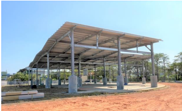
鋼構太陽能風雨球場
