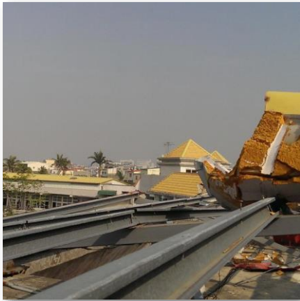
頂樓屋頂修繕
