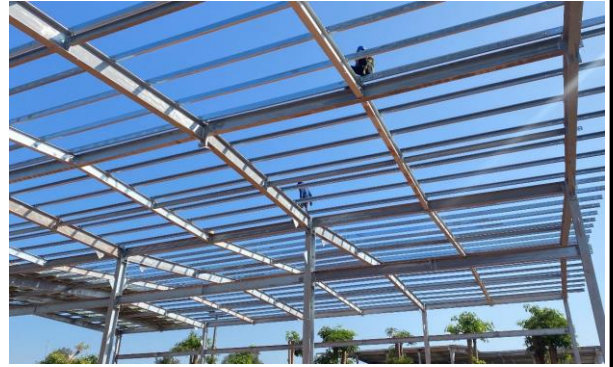
鋼構太陽能風雨球場
