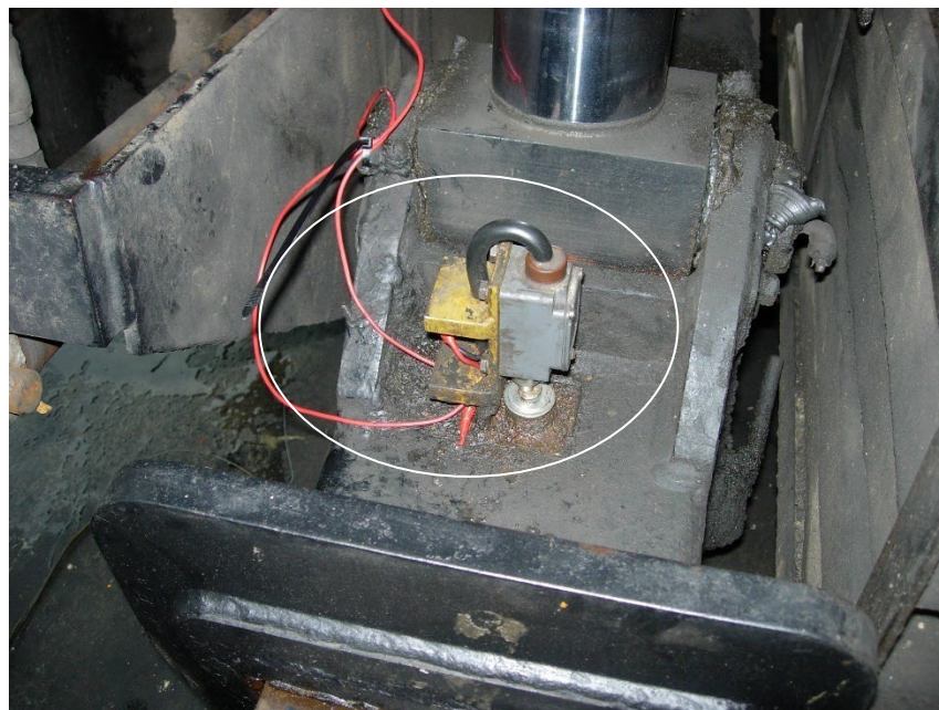
樑箱、撐樑分離感應裝置 之安裝(取去護蓋)
