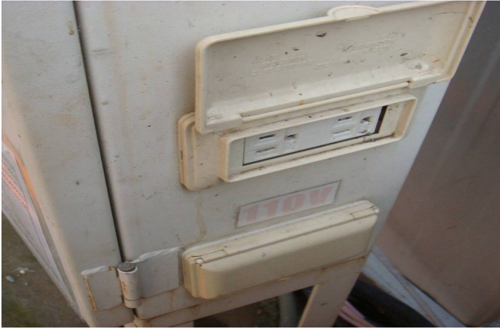
配（分）電箱旁外部設置加蓋之插座孔裝設 110V 之插座。
