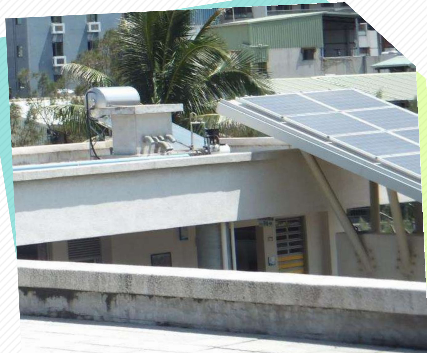
太陽能板設置作業
