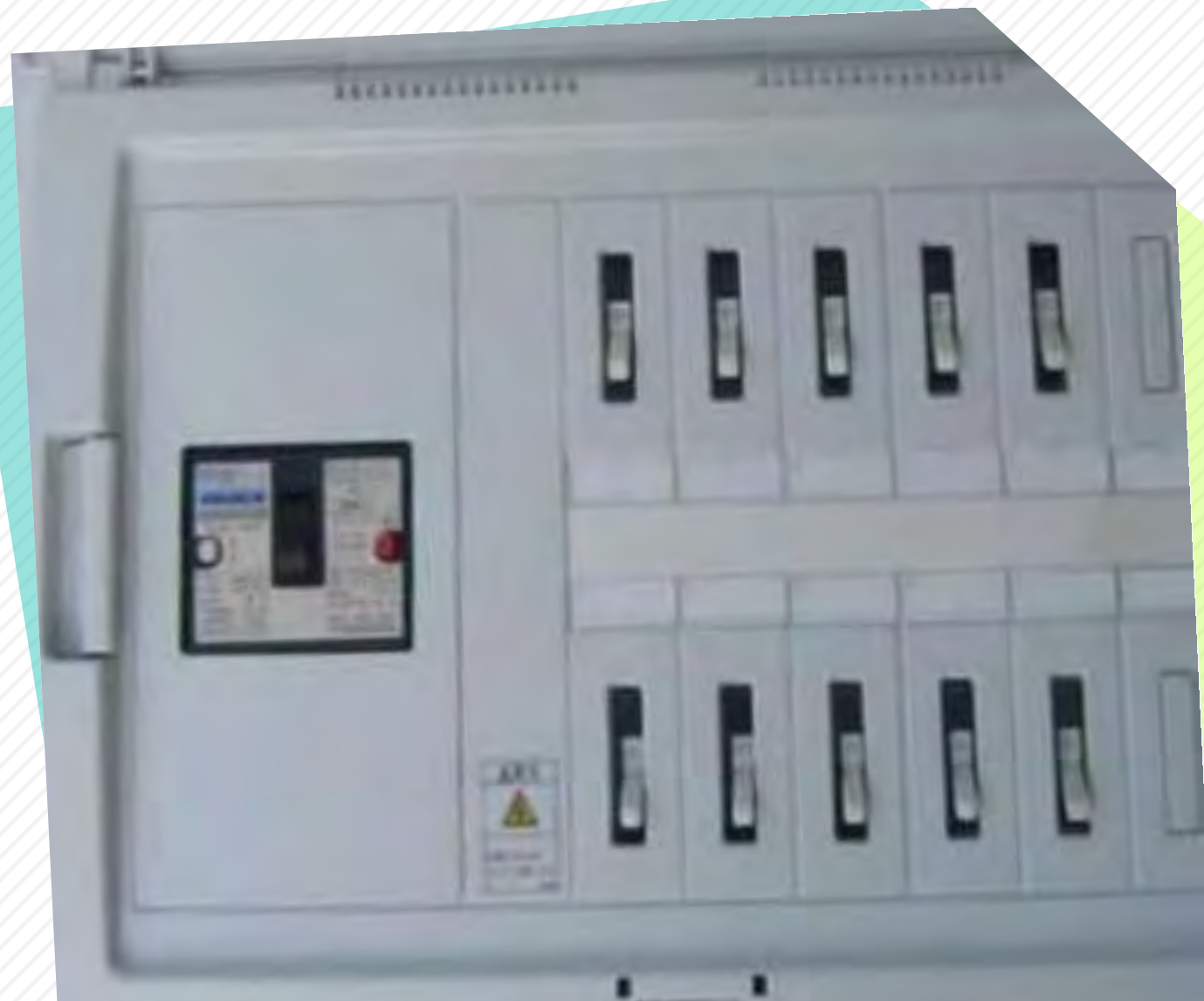
中隔板、分路標示
