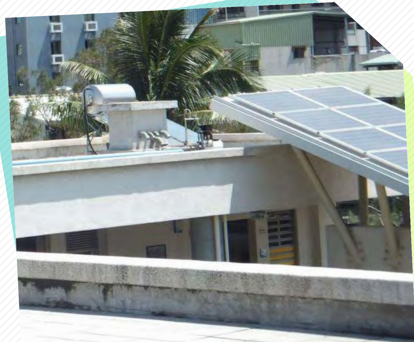
太陽能板設置作業
