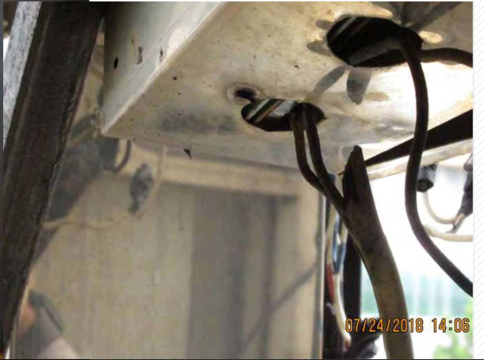
開關箱漏電處
