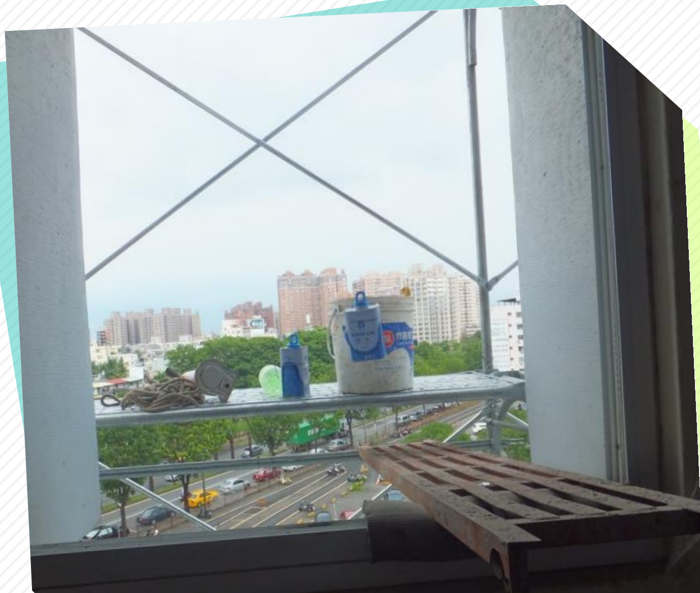
未設交叉拉桿、下拉桿
