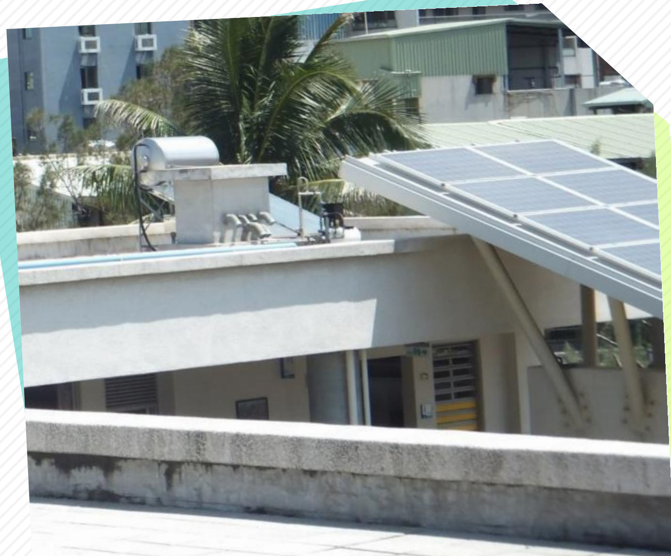
太陽能板設置作業
