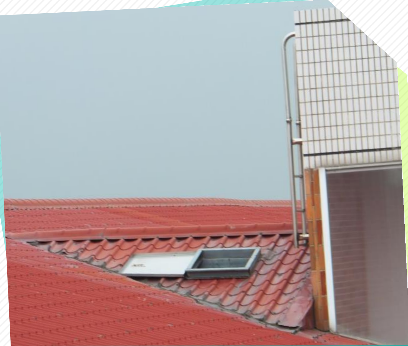
水塔設置及動線規劃不當
