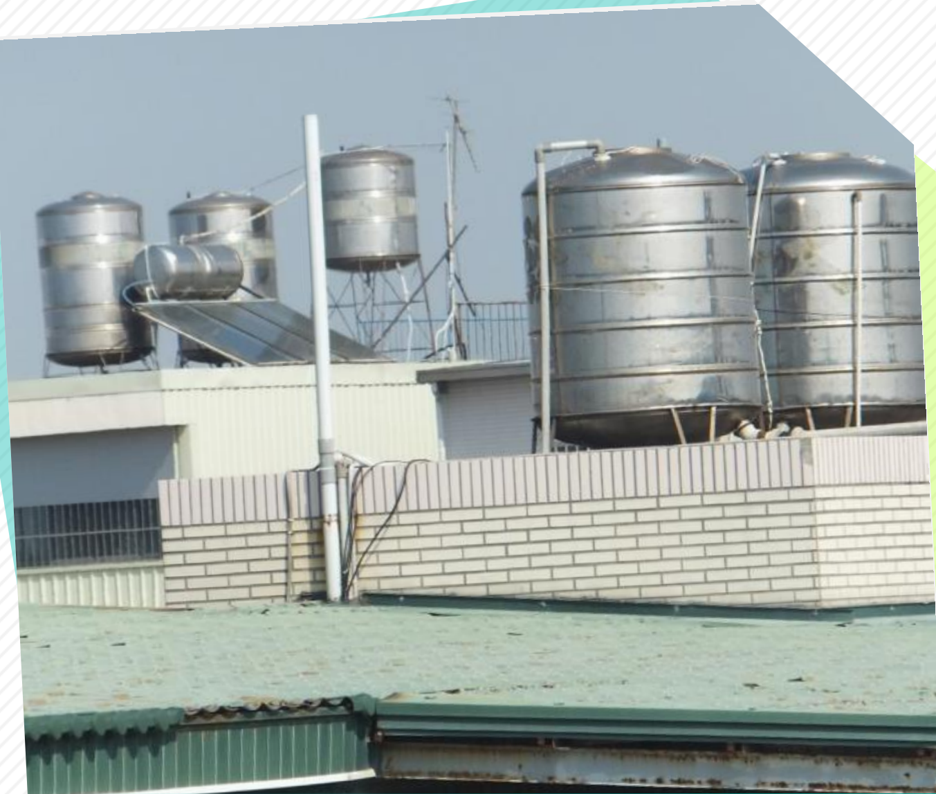
水塔設置及動線規劃不當
