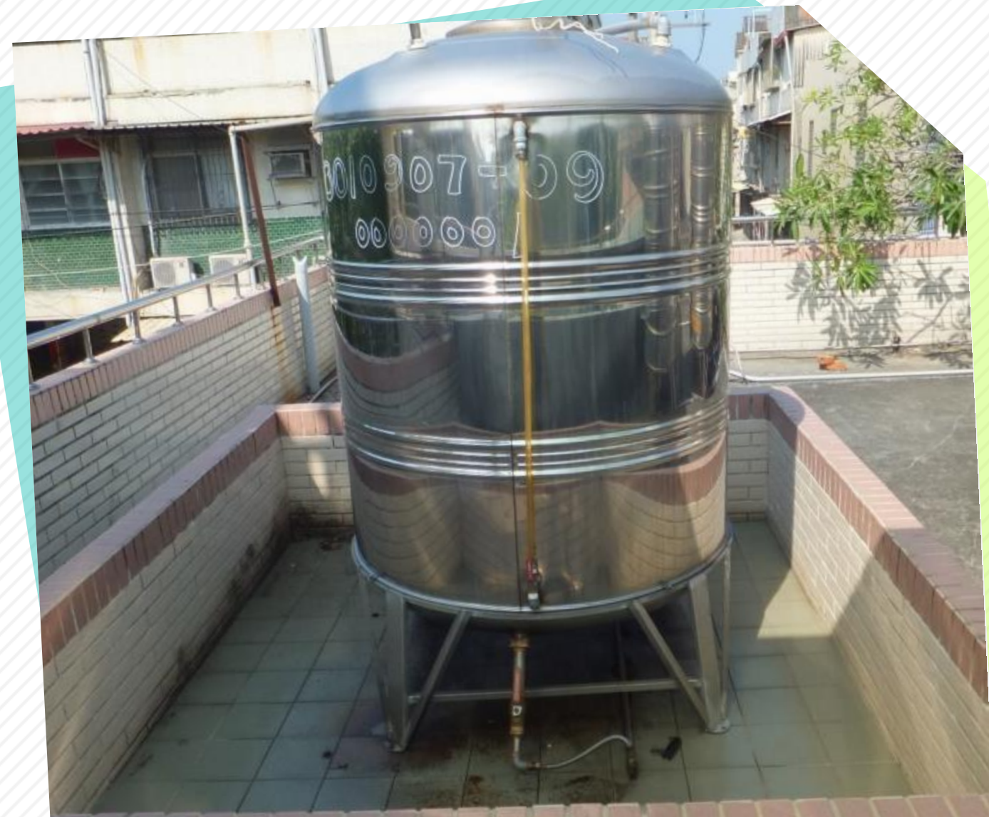
鍋爐柴油未依規定標示
