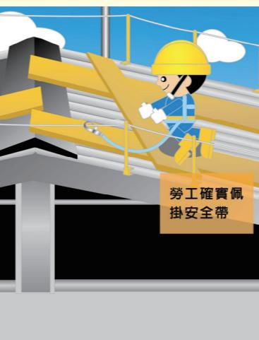
六、高度 2 公尺以上之模板組立作業，應架設工架或其他方法設置工作台供勞工作業使用，勞工從事作業應確實使用安全帶。
