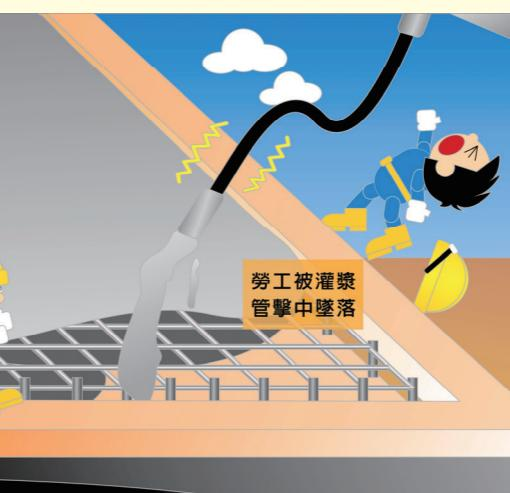
五、高度 2 公尺以上之鋼筋綁紮作業，應架設施工架或其他方法設置工作台供勞工作業使用，勞工從事作業應確實使用安全帶。
