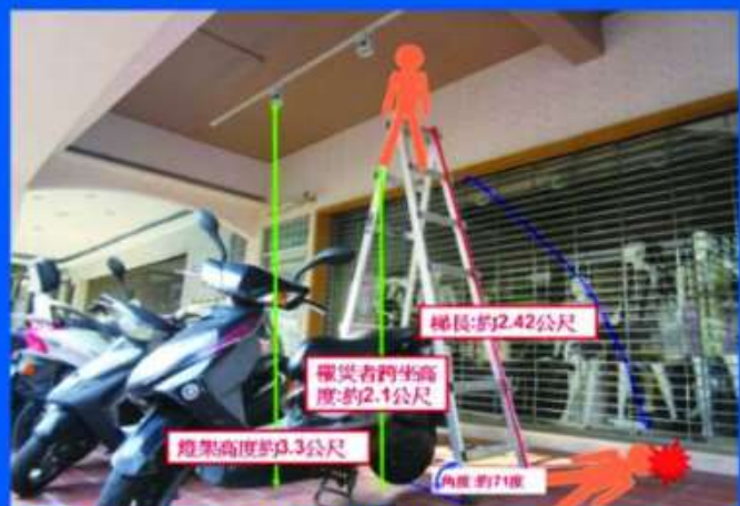
跨坐超過高度2公尺合梯梯頂作業時墜落致死。
