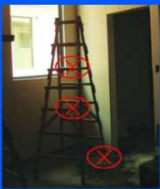
木質合梯未有安全梯面、兩梯腳間有金屬等硬質繫材扣牢、腳部有防滑絕緣腳座。
