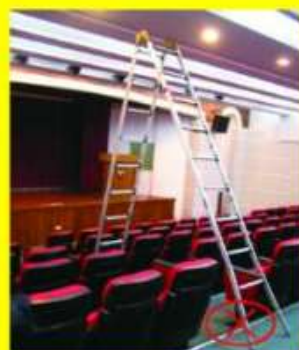
不得將合梯放置於具高低差階梯等不穩定處供勞工作業。
