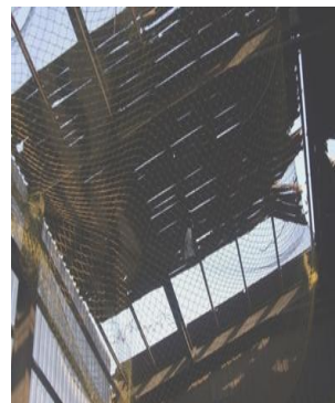
↑ 施作區域設安全網
