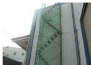
← 內爬梯式施工架
