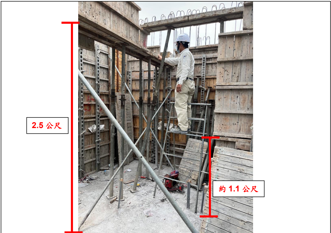
說明二 模擬王○○於 J1 樑側模組立作業，作業時站立高度約 1.1 公尺；樓面至樑底高度 2.5 公尺。
