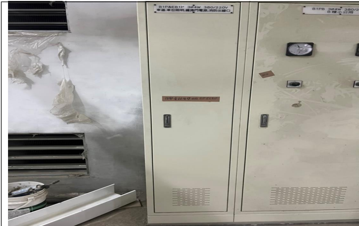
說明一 B1 消防設備電氣箱無上鎖，亦無標示「禁止送電」、「停電作業中」。
