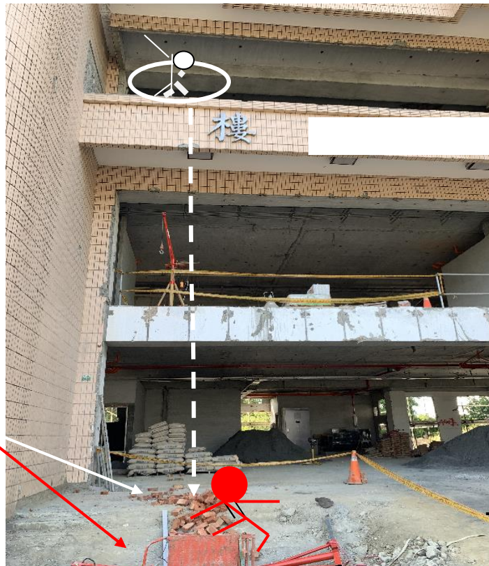
說明二 ○○樓 3 樓吊掛處及墜落地點高度及捲揚機散落位置。
