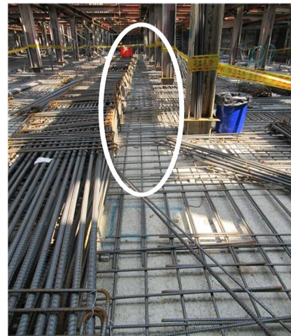
東側設置 #5 斜撐筋
