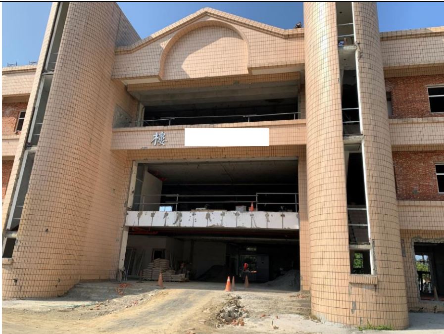
說明一 ○○營區○○樓整修工地。
