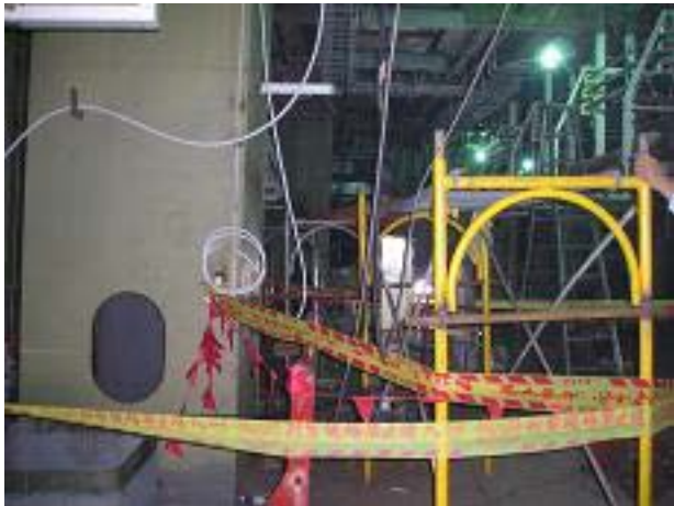
管路支撐架與施工架。
