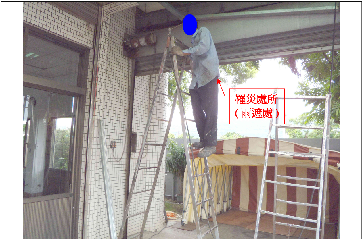
照片 1、罹災者站立於高約 165 公分合梯踏階從事電焊作業。(模擬照片)
