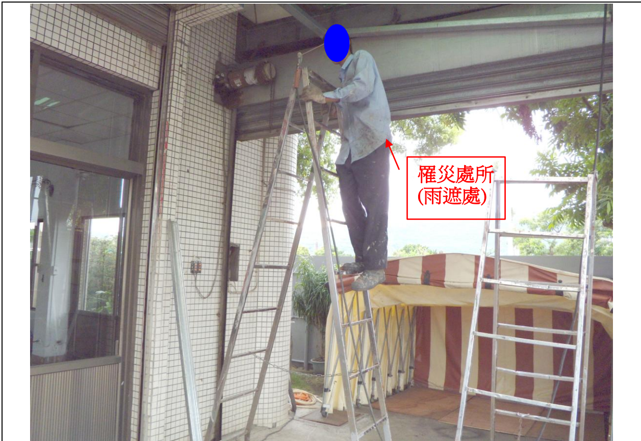
照片 1、罹災者站立於高約 165 公分合梯踏階從事電焊作業。(模擬照片)
