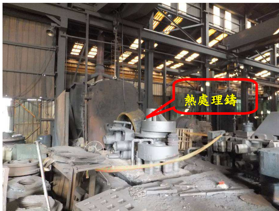
照片 1 肇災現場：災害現場位於退火爐
