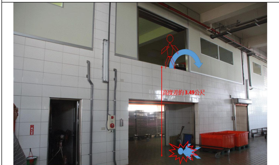
罹災者甲自高度差約 3.49 公尺處墜落至 3 樓樓板。
