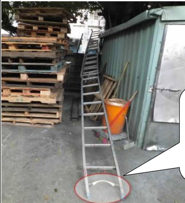
圖 2 僱主(保安消防實業有限公司)對於使用之移動梯，未符合具有堅固之構造及採取防止滑溜或其他防止轉動之必要措施。
