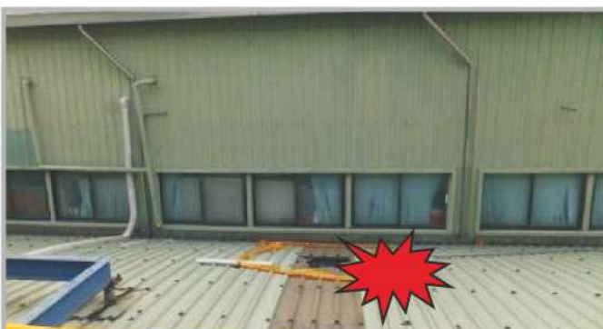
從事空調設備安裝作業，於遮雨棚因 踏穿採光浪板 墜落致死災害
