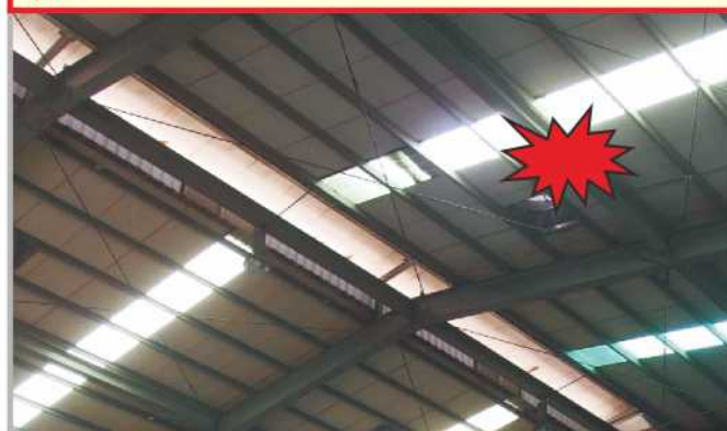
從事廠房屋頂維修作業，因 踏穿採光浪板 墜落致死災害
