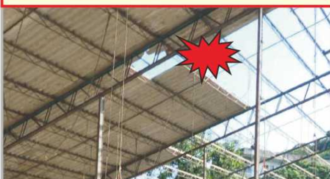
從事空調設備安裝作業，於遮雨棚因 踏穿採光浪板 墜落致死災害
