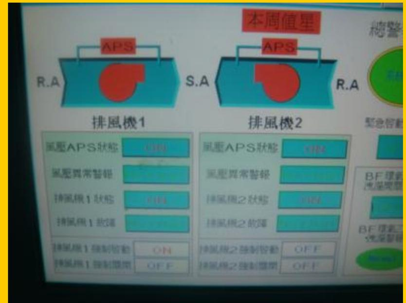
抽氣排風自動控制系統（設定容許濃度值及觸控式面板）
