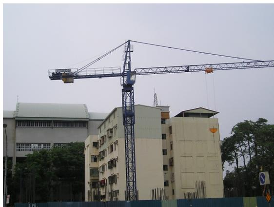
圖 1 鉗頭型塔式起重機
