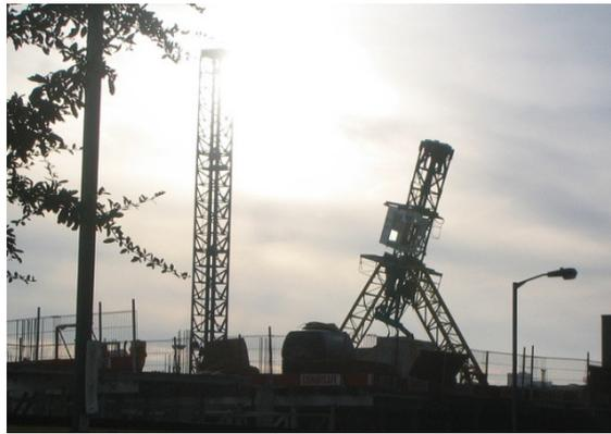
圖 14 塔氏起重機旋轉盤脫落事故
