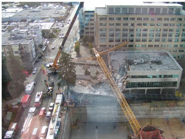
圖 15 塔式起重機基礎承载力不足造成倒塌事故(資料來源：<http://lni.wa.gov/>)
