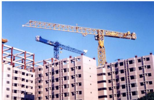
圖 3 平頭型塔式起重機
