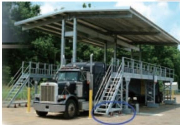
圖8 固定式裝卸作業平台
