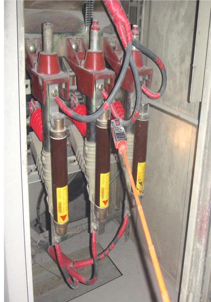
作業人員未以絕緣防護裝置操作高壓電設備而感電。
