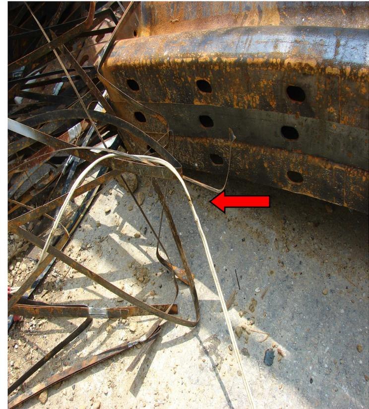
發現缺失：現場臨時用電線路置放地面，受外力致絕緣遭破壞造成短路及漏電。
