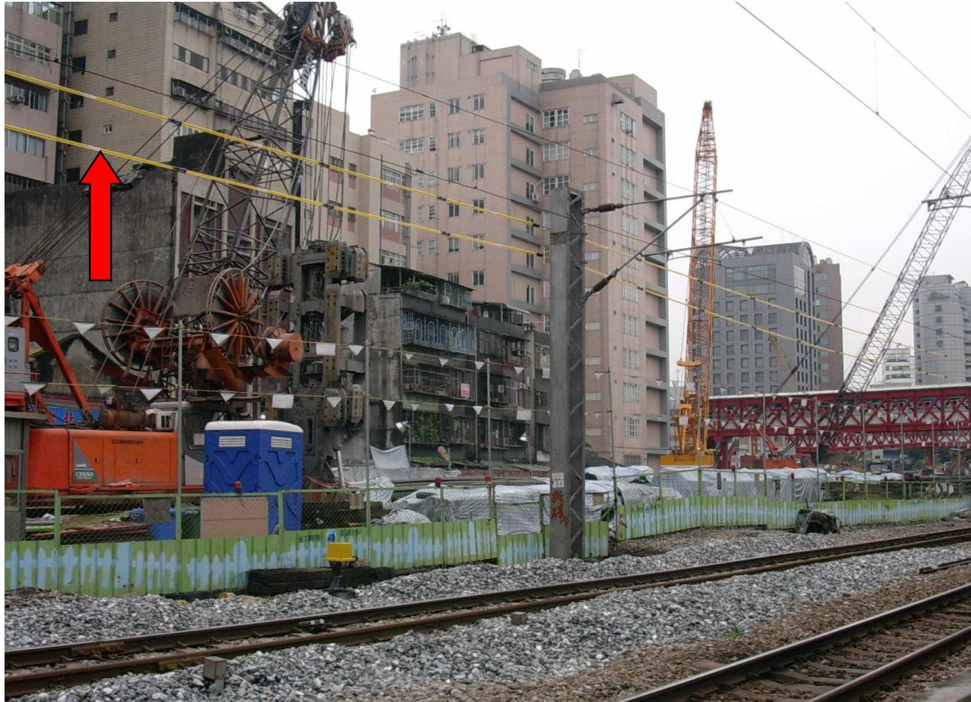
接近高壓電線作業應事先加裝絕緣護套等防護
