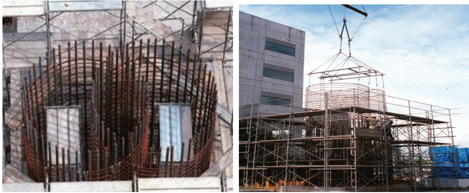
圖 21 日本 TRiC 工法現場使用情形
