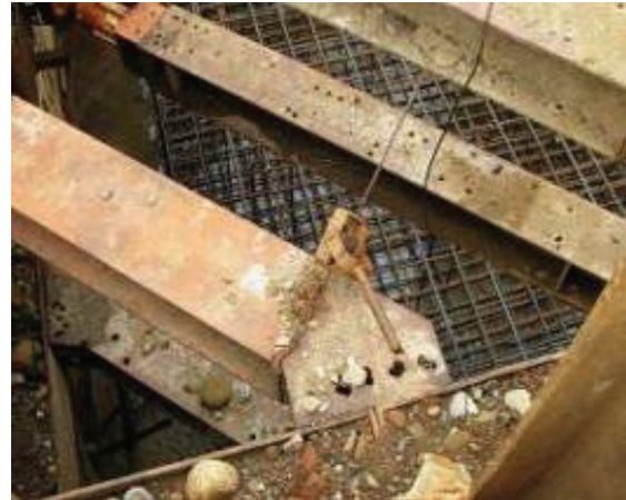
圖 10 以調整器錨定在擋土支撐上
