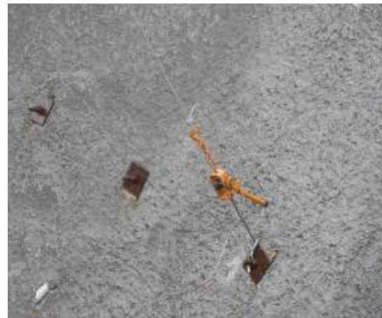
圖 12 以調整器錨定在岩錨上
