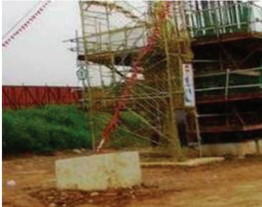
圖 9 以緊張器錨定在混凝土塊
