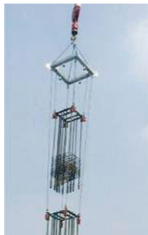
圖 18 使用自動脫鈎器應用於吊掛鋼筋樣架
