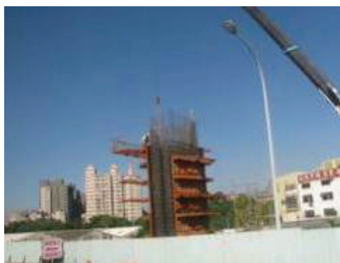
圖 14 人員在高處進行吊掛作業
