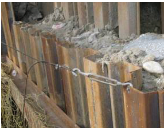
圖 11 以緊張器錨定在鋼板樁
