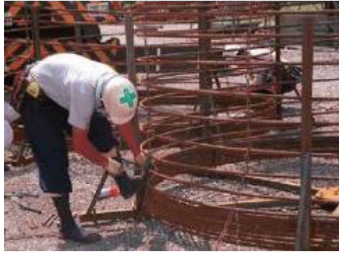
圖 22 從地面組搭螺旋配筋
