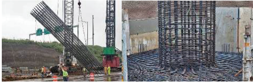
圖 24 美國橋墩施工方式
