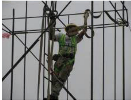
圖 17 人員由樣架內爬梯進行脫鉤作業
