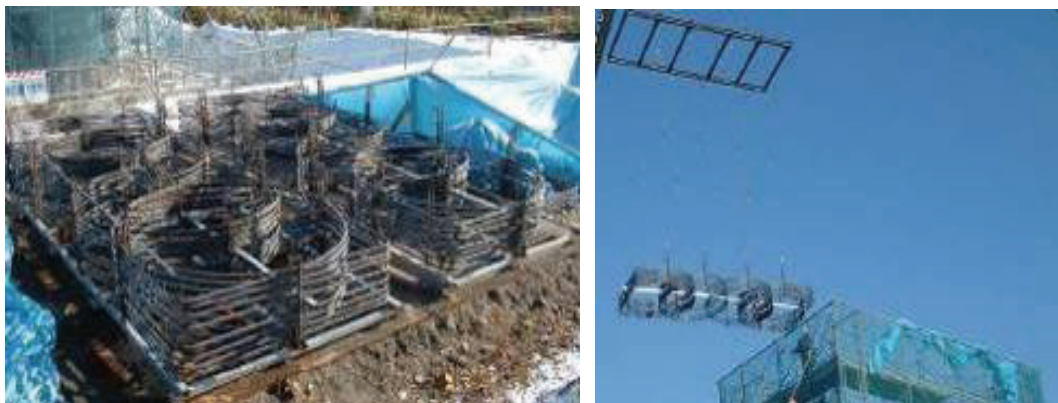
圖 23 地面組裝圓形帶狀鋼筋及吊裝
