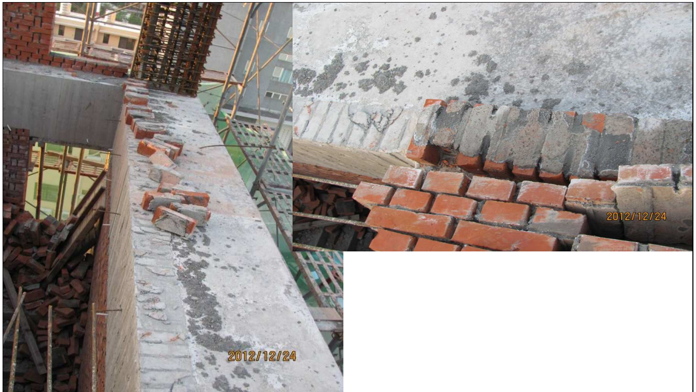
照片 3：倒塌磚牆第一層磚現況。
