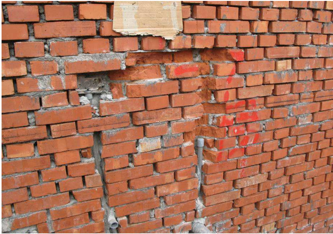
照片 5：水電配管打鑿情形。
