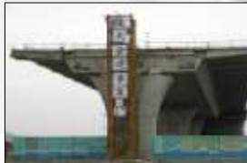
橋面板上下設備
