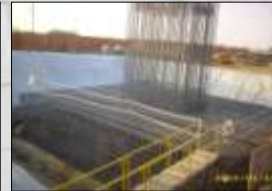
基礎開挖面邊坡防護措施
