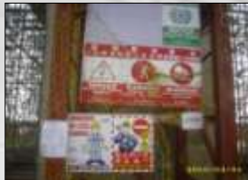
上下設備設置警告標誌
