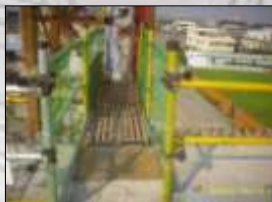
上下設備設置走道至橋面板
