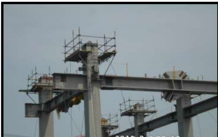
搭設焊接施工平台
