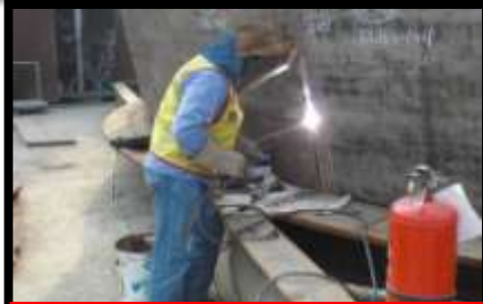
作業人員PPE佩帶完整
