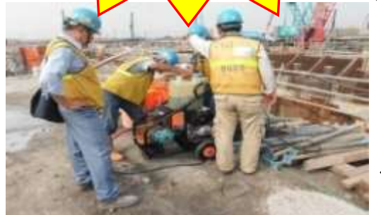
六.每日實施之動態管理制度,可有效消除現場作業的剩餘風險。
