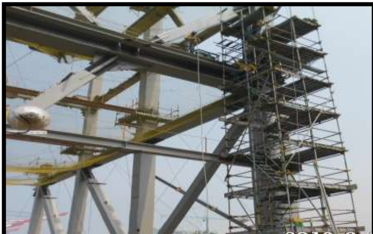
搭設上下設施供施工人員使用
