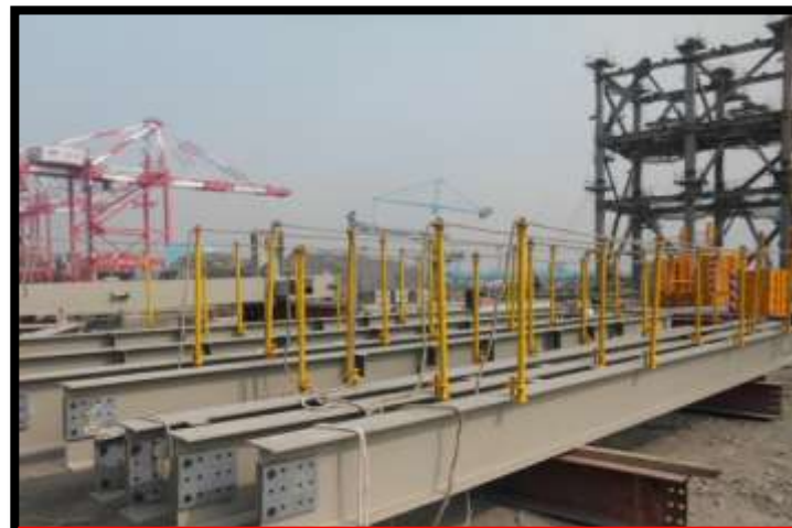
地面上架設安全母索、減少高空作業
