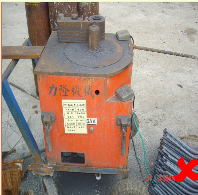
彎筋機未實施接地
