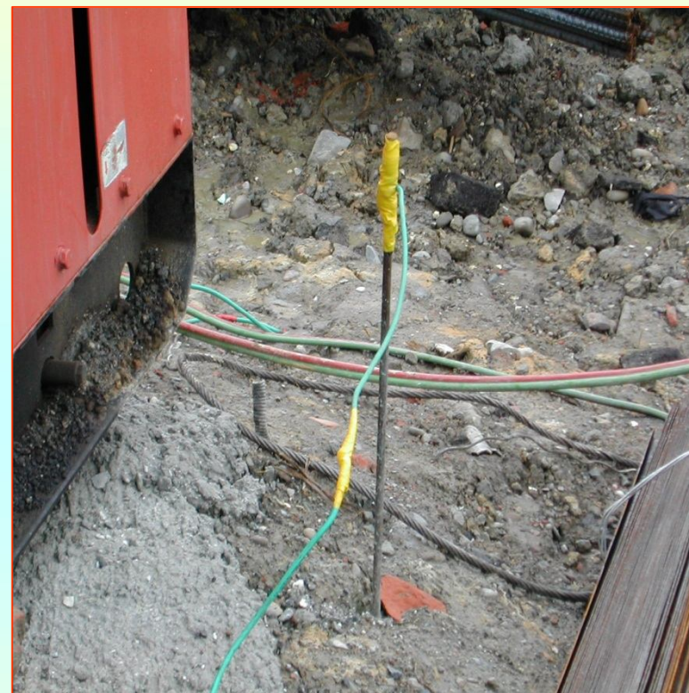
設備未帶電金屬部份實施 接地
