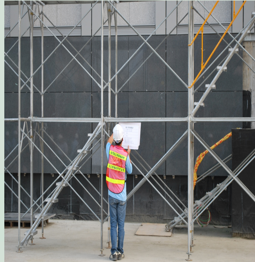
搭設完成後，經作業主管檢查並放置施工架載重告示
