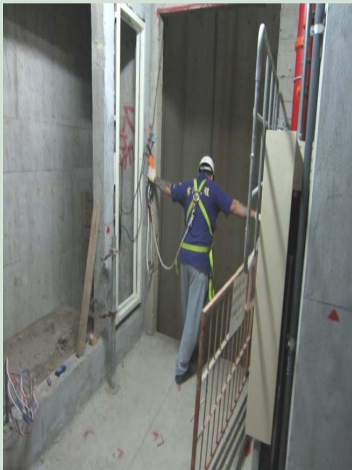
勞工於電梯口吊料， 須確實勾好安全帶
