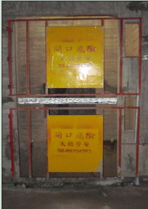
電梯開口須設置可開啟式金屬護欄(雙閘門)，並張貼警語
