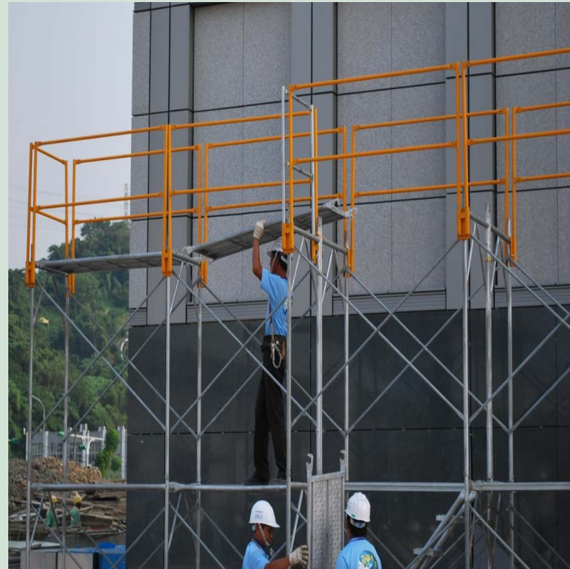
施作上層踏板
