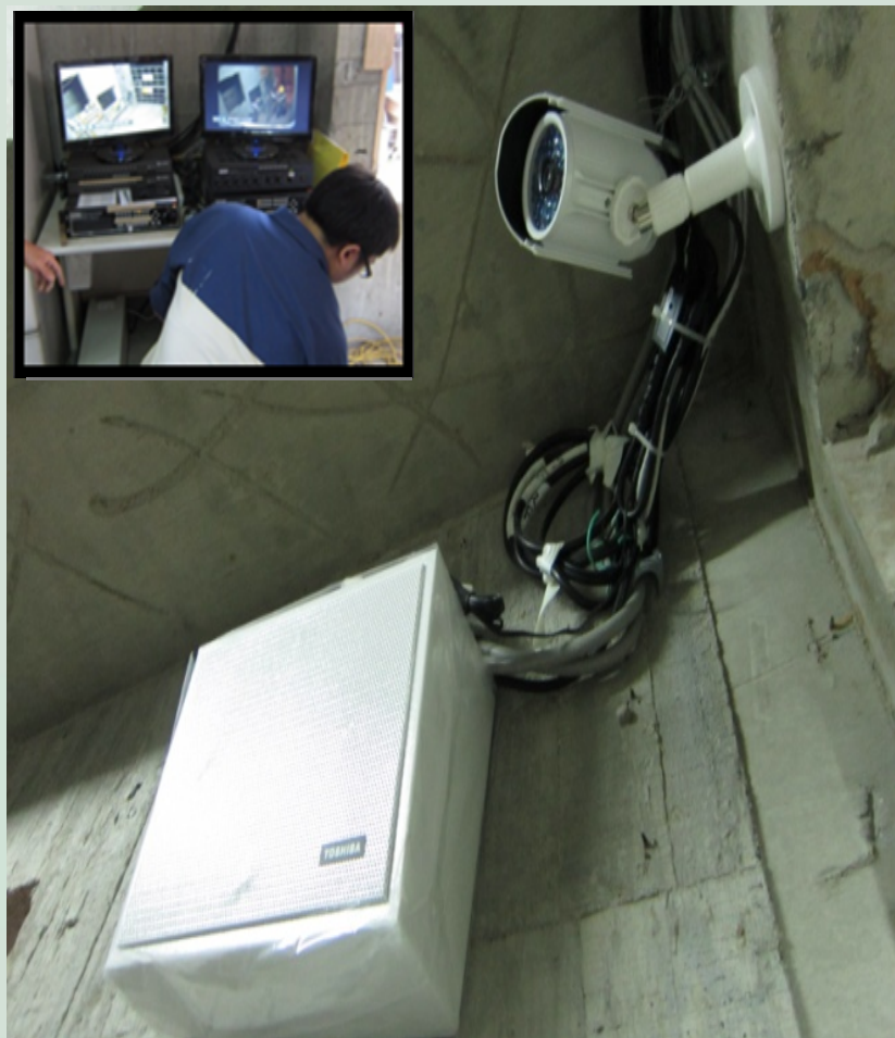
開口處設置監視器， 申請吊料監控管制
