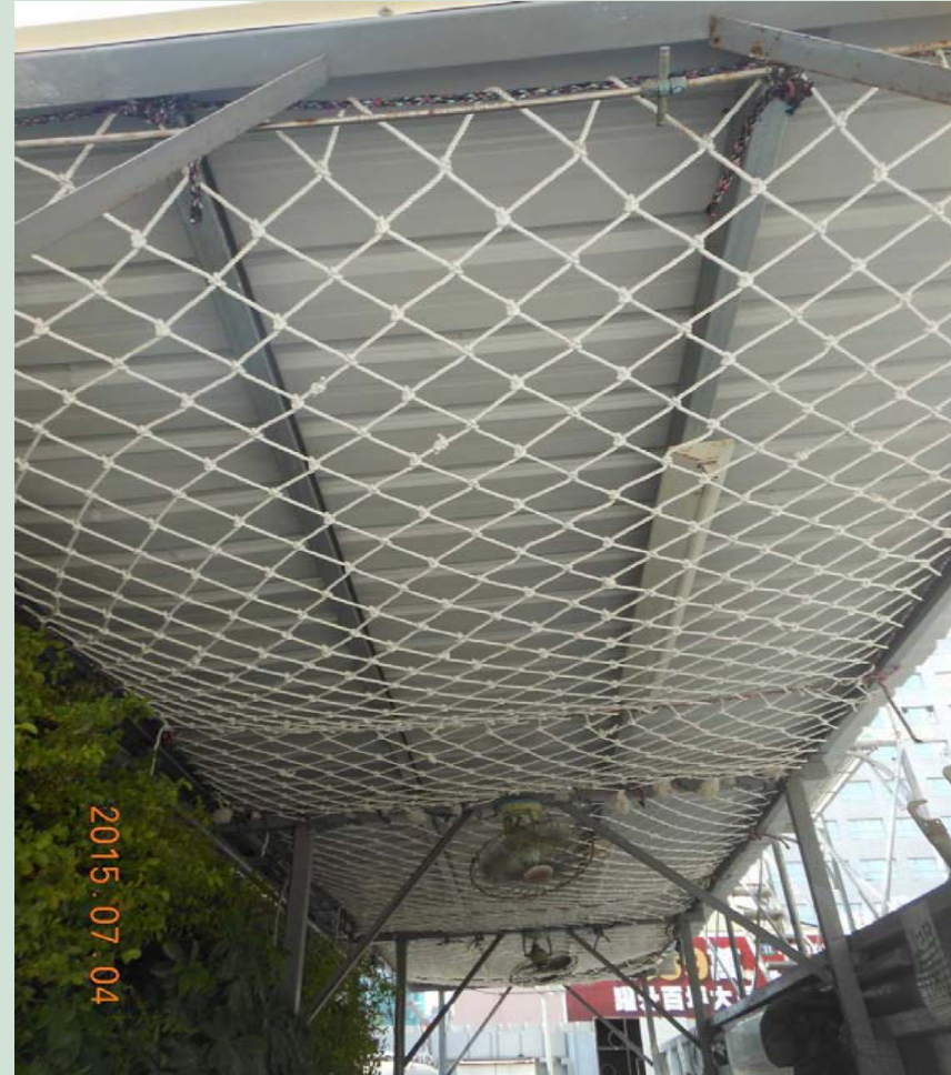
屋頂屬易踏穿材料時須加裝防墜網
