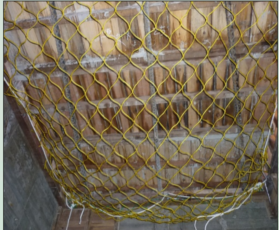
拆模階段之防護措施(下視圖)
