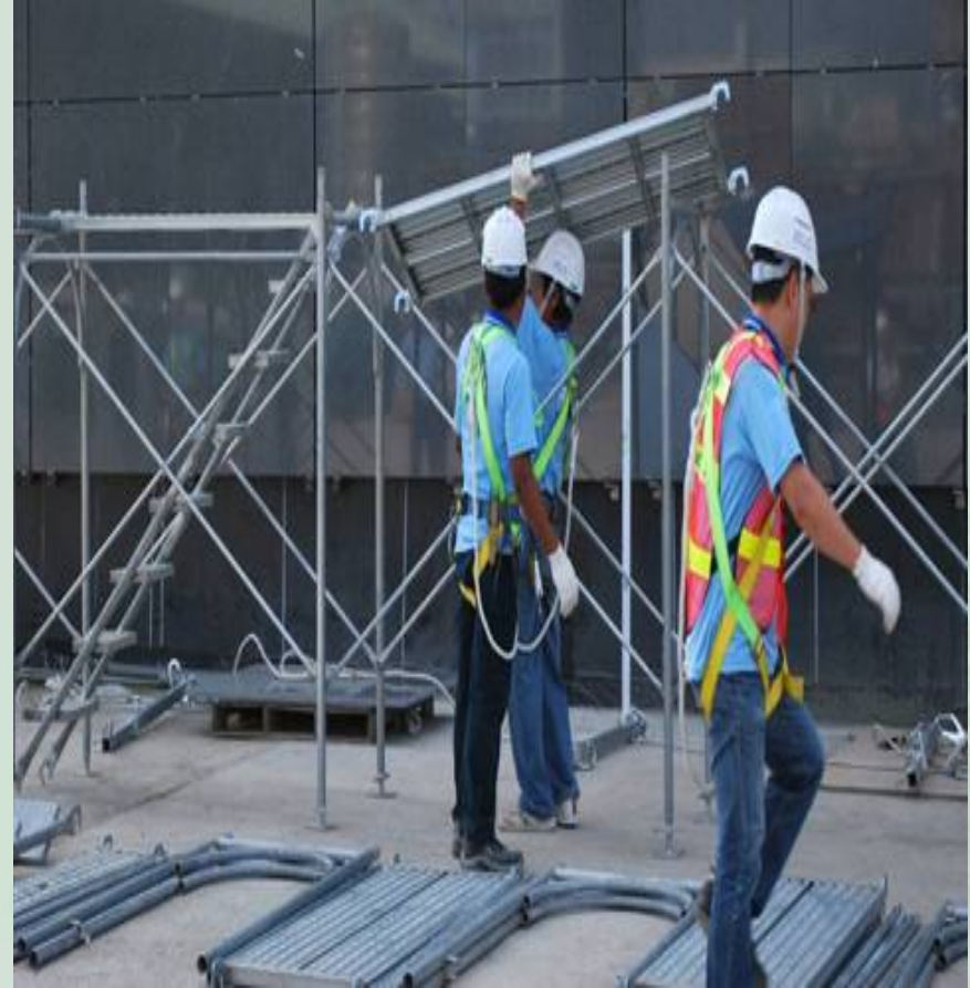
組立第一層立架與交叉拉桿
