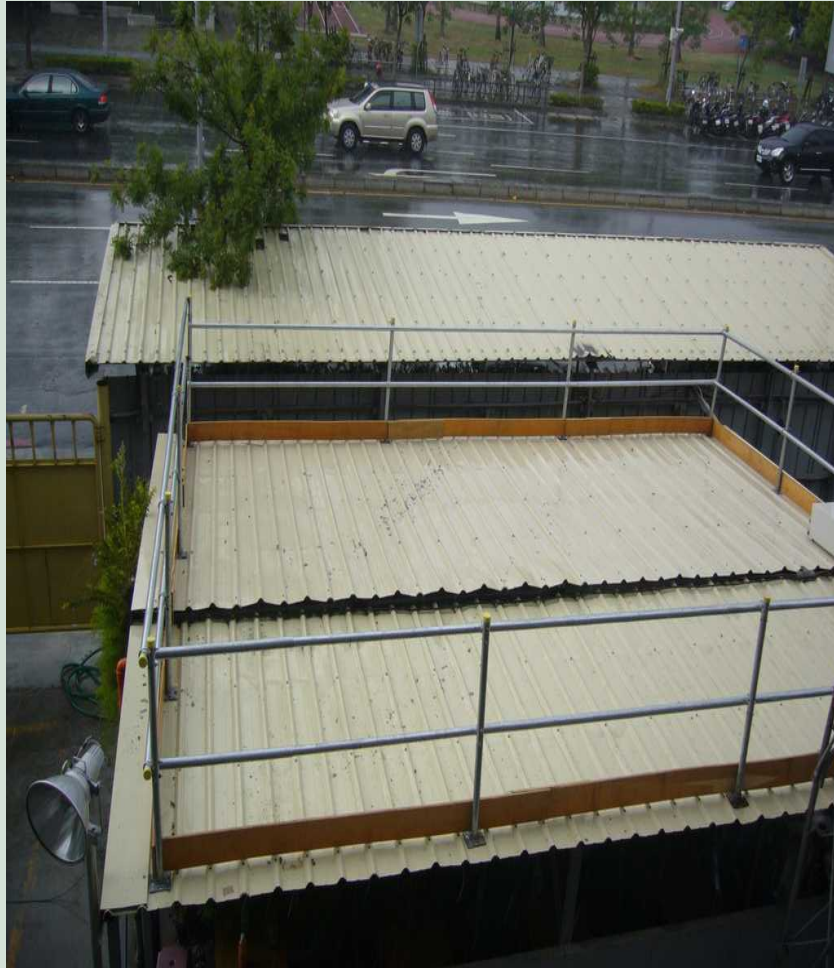
屋頂作業安全欄杆
