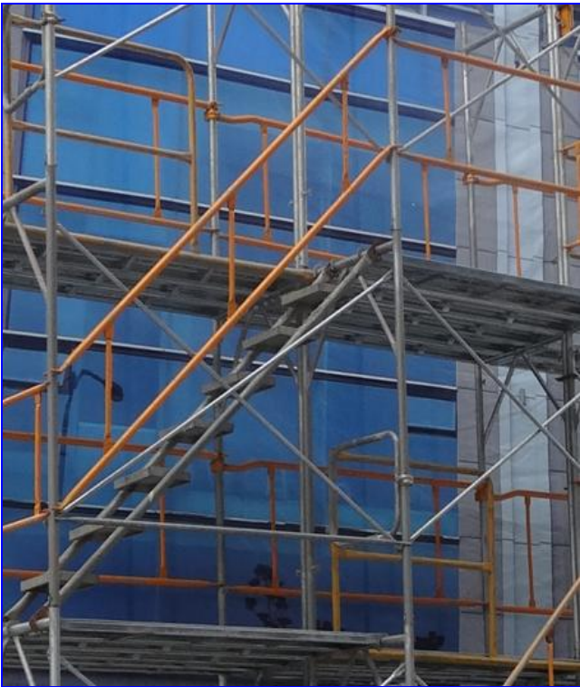
照片 2：上下設備樓梯應有適當護欄（得採足以防護工作者墜落之 上拉桿等設備固定於上端交叉拉桿扣釘之方式 代替）。
