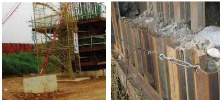
圖3：斜拉鋼索與支持物固定
