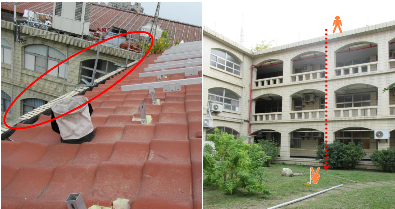
(b)罹災者自屋頂邊緣高度約 10 公尺墜落至地面示意圖。
