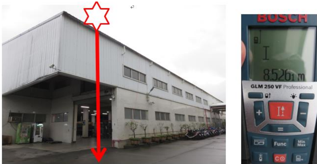
(b) 勞工洪○○走向屋頂邊緣要撿起該手工具時，墜落至地面高度示意圖。
