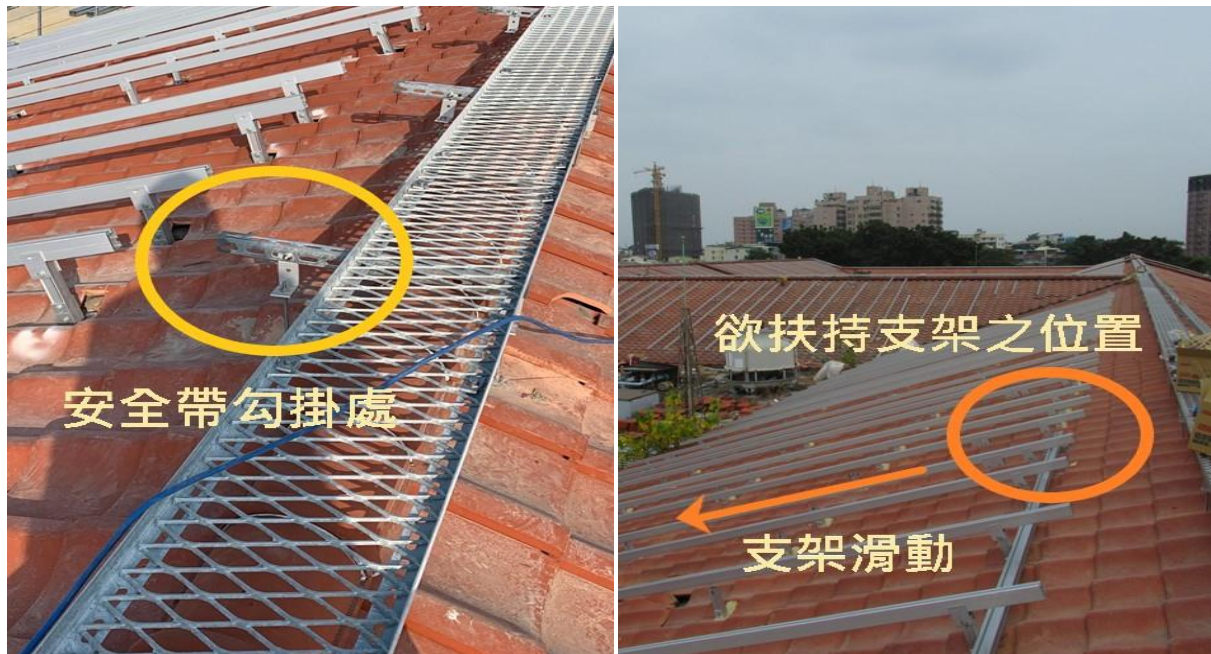
(a)災害發生地點之安全帶勾掛處與欲扶持支架滑動之位置示意圖。
