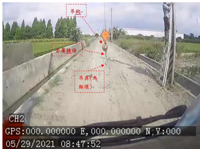
(a)移動式起動機吊具與鄧○○災害發生前站於合梯上相對位置。
