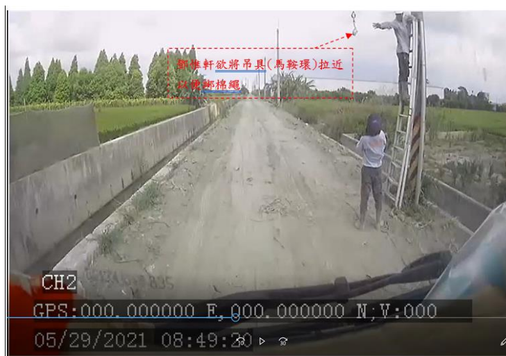
(b)鄧○○欲將吊具(馬鞍環)拉近以便綁棉繩，致發生感電。
