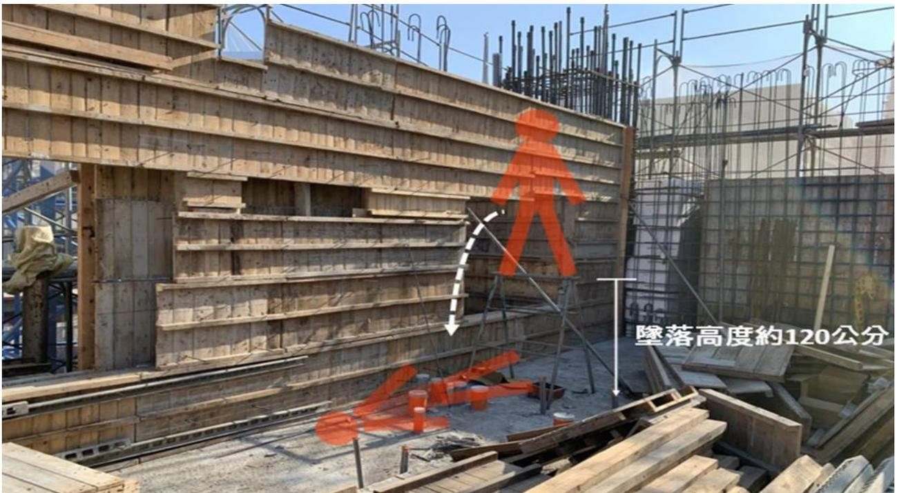
▲ 罹災者站在合梯頂板作業，自頂板上墜落撞擊樓板面水管。
