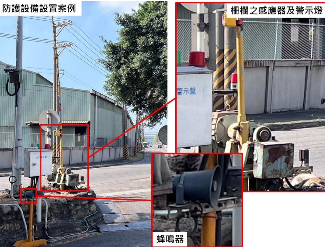
▲圖 2.利用警示燈、蜂鳴器及柵欄等使人員提高警覺
