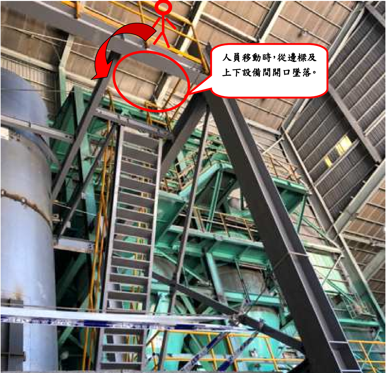
事故現場照片(從開口墜落)
