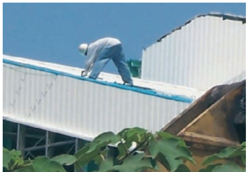
▲高度2公尺以上屋頂作業勞工有墜落之虞，未妥善規劃防墜設施。
