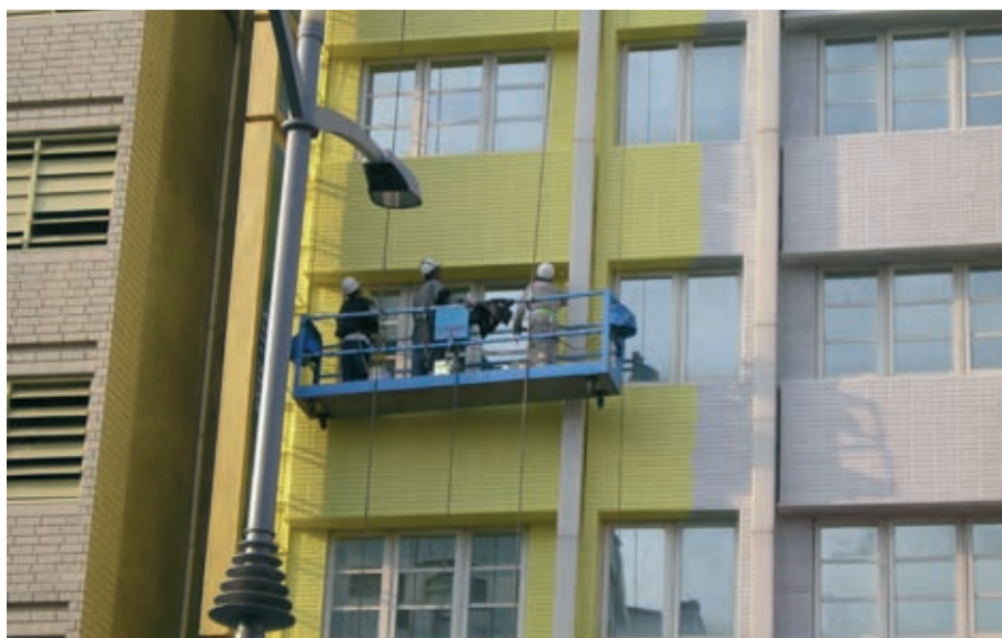
▲吊籠作業需做好防墜設施
