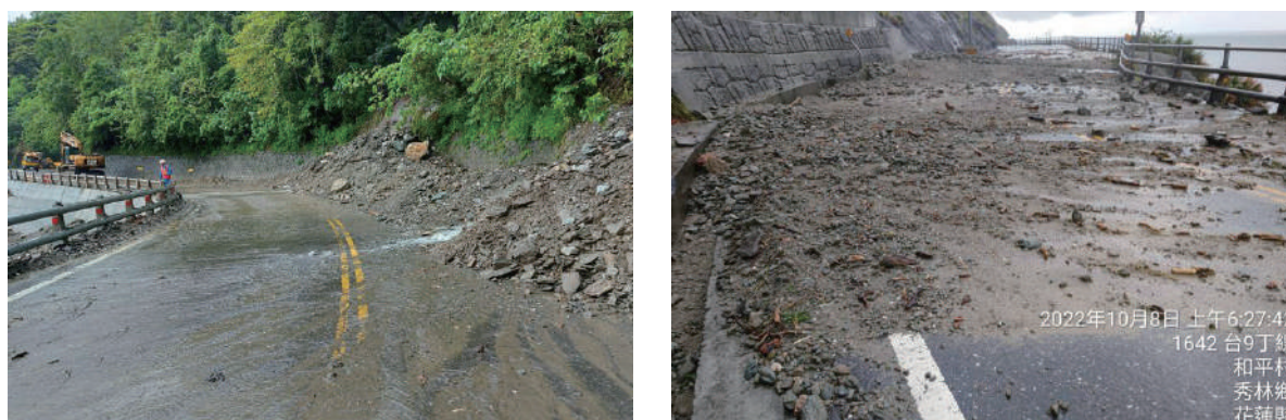
圖 3-9、東北季風降雨異常，蘇花路廊台 9 丁線（舊蘇花公路）因土石泥流沖刷，封閉部分路段
