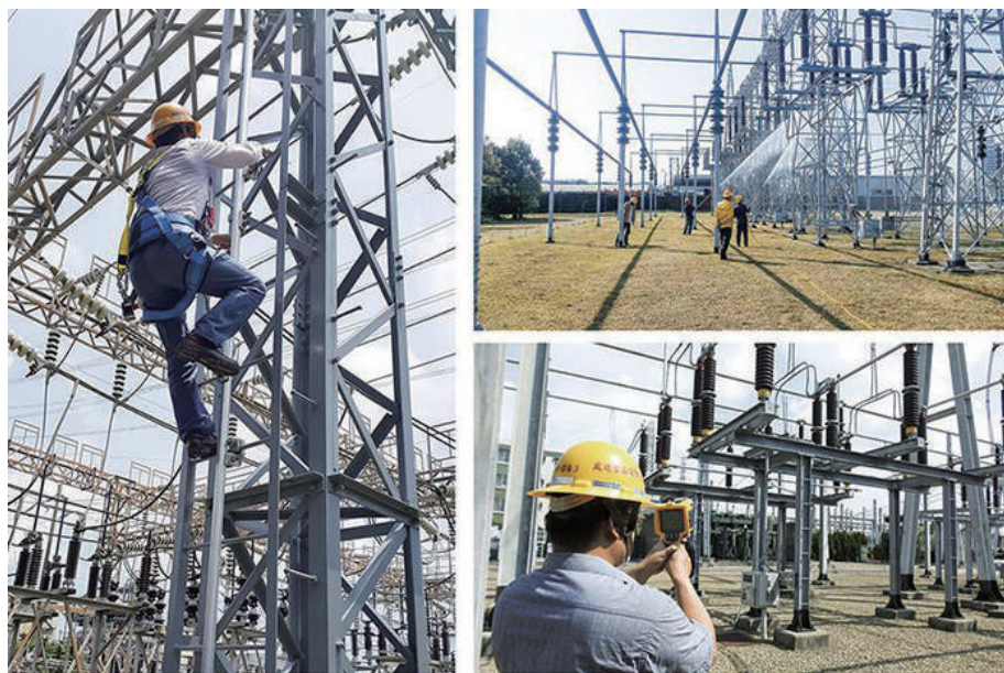
圖 3-8、變電所架空地線檢查作業；變電所活掃作業；輸變電設備外部診斷紅外線檢測作業
