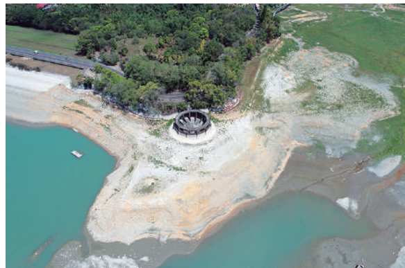
圖 3-2、大旱期間日月潭水庫探底，溢流井設施與邊坡完全裸露 資料來源：台灣電力股份有限公司
