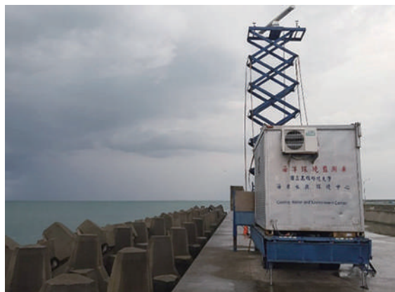
圖 4-28 台灣中油股份有限大林廠 2 號浮筒油管滲漏事件雷達監測位置
