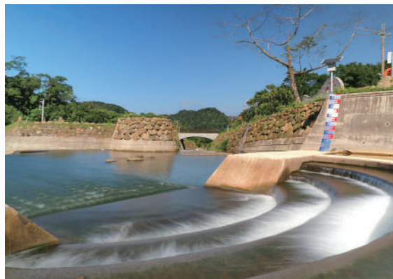
圖 4-61 臺中新社區抽藤坑溪整治工程
