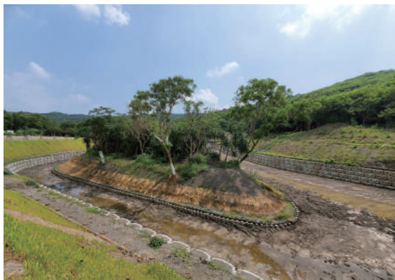
圖 4-60 屏東縣恆春鎮野溪整治工程
