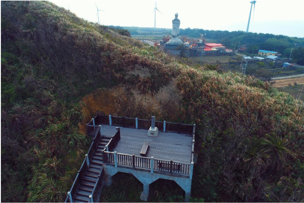
圖三、自然紀念物 II 區，過港隧道旁紀念碑後出露剖面。
