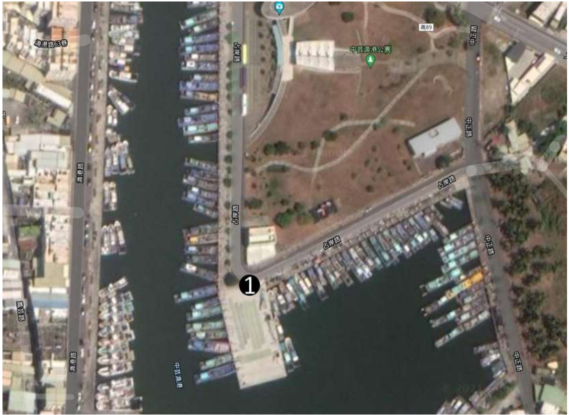
圖 55 中芸漁港靠近公園空照圖
