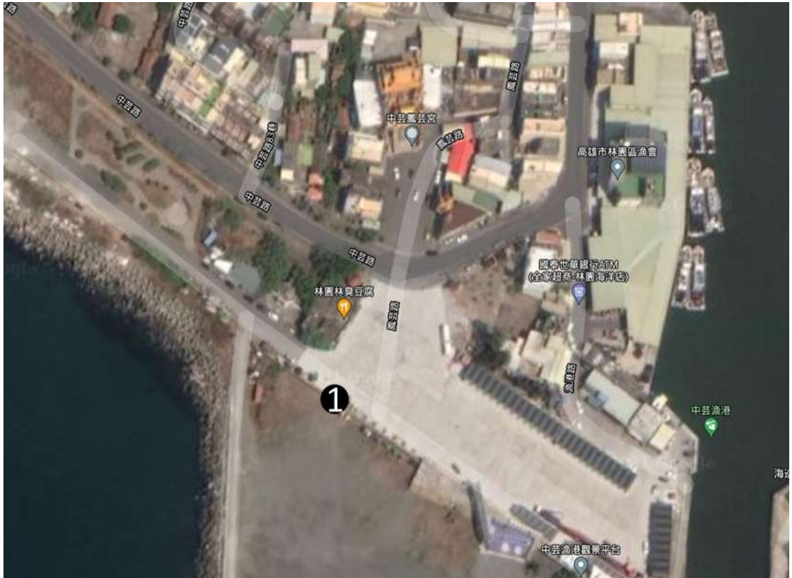
圖 58 中芸漁港景觀平台旁堤岸樓梯右側空照圖
