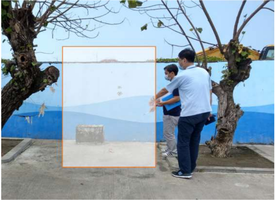
圖 60 中芸漁港景觀平台旁堤岸樓梯右側現場勘察示意圖 (5) 前鎮區
