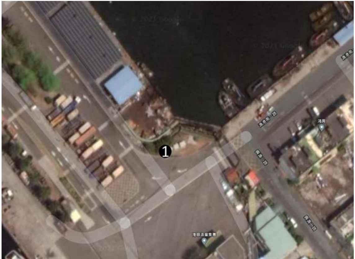
圖 61 前鎮漁港管制站變電箱旁花圃空照圖
