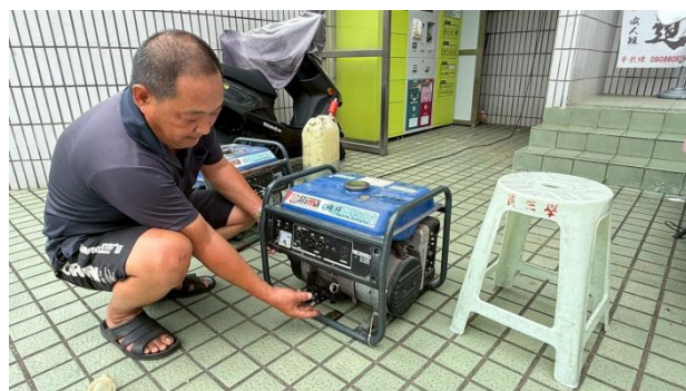
廠商進行發電機異常排除
