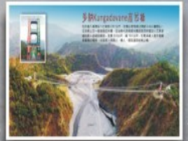
7.多納Kungadavane高吊橋
