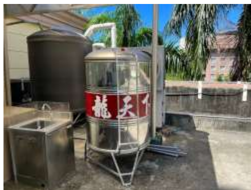
圖 4-3 施工前：儲水桶定位
