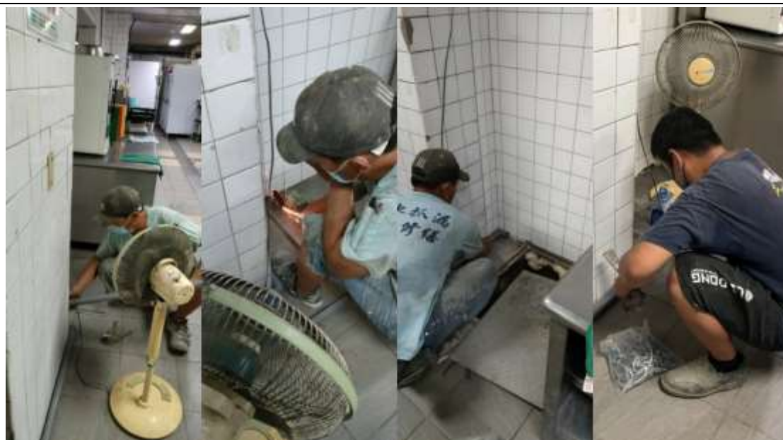
圖 4-5 再利用管路配至本院地下水池
