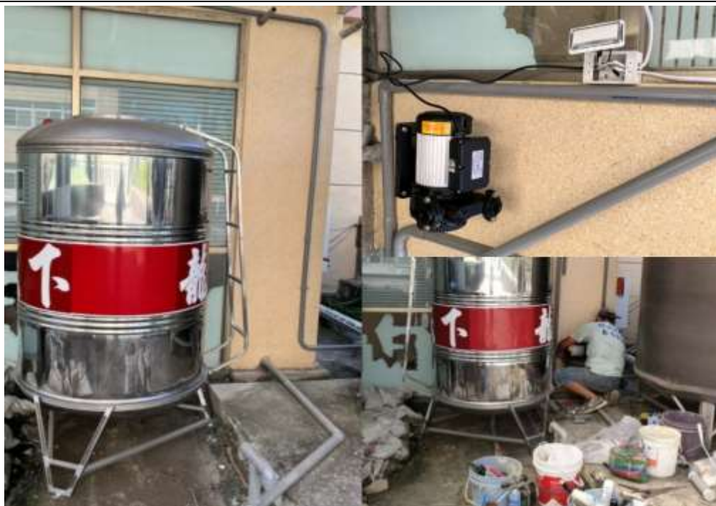
圖 4-6 管路銜接再利用設備及安裝馬達
