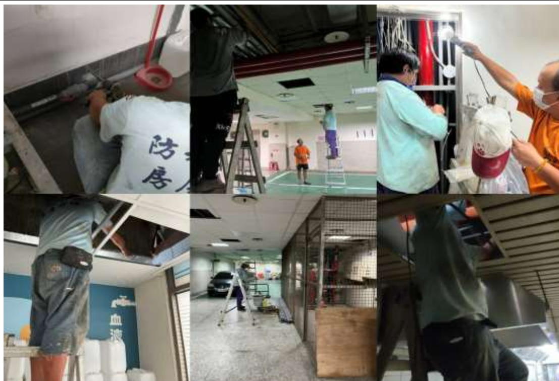
圖 4-4 施工中：洗孔及配管
