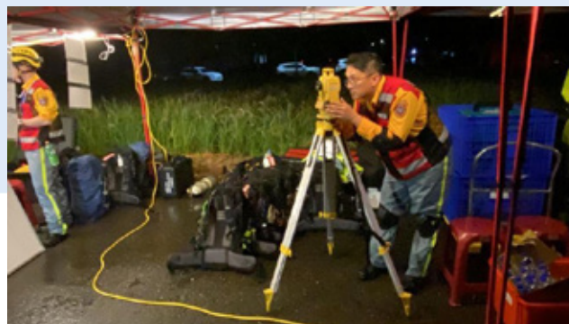
▲土木技師評估建築物結構情形，協助引導搜救人員建立安全搜救位置
