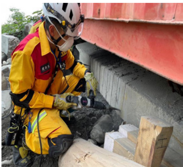
▲ 搜救組破壞混凝土能力
