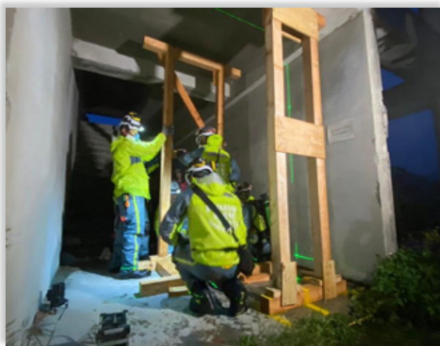
▲ 搜救組支撐作業
