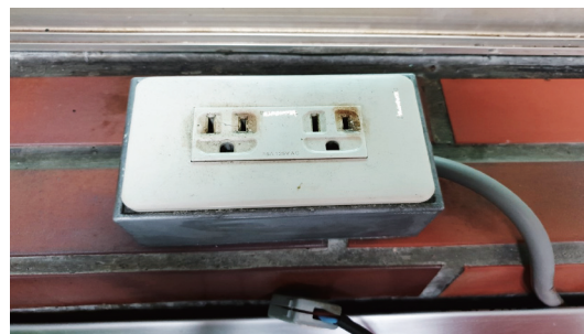
圖 8. 插座孔焦黑之情形
