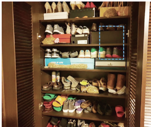
圖 1. 配電箱被遮蔽之情形
