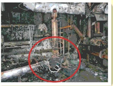
圖二、降壓閥法蘭乙稀洩漏處
