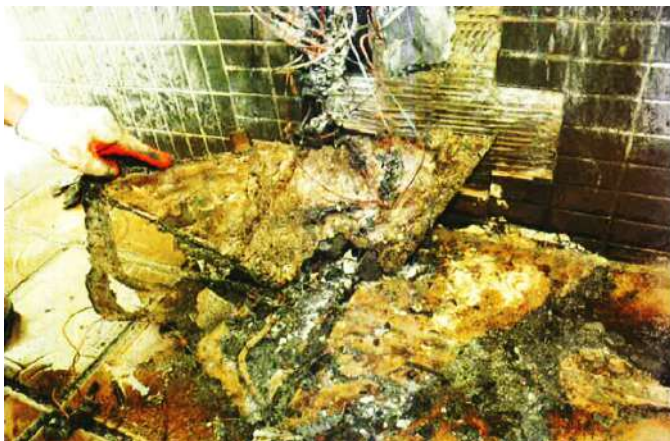
▲圖2 直流分接箱熔凝殘跡
