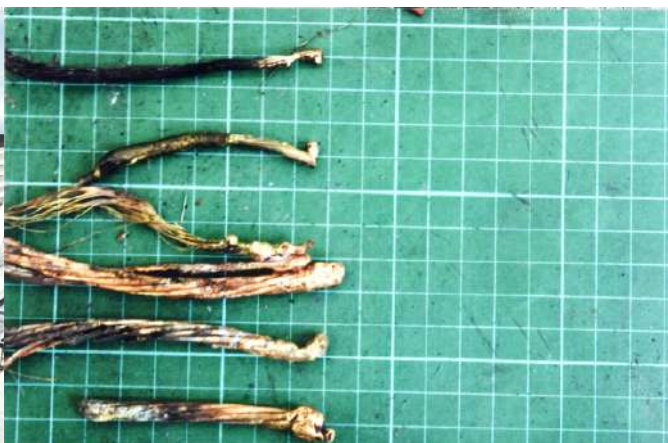
▲圖5 配電箱內電源線短路熔痕
