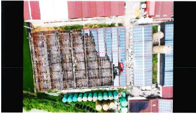
▲圖 6 豬舍 7 屋頂燒損情形
