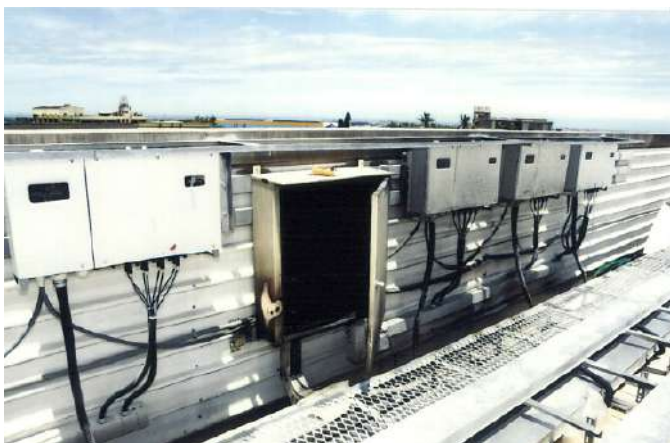
▲圖4 太陽能直流配電箱受燒
