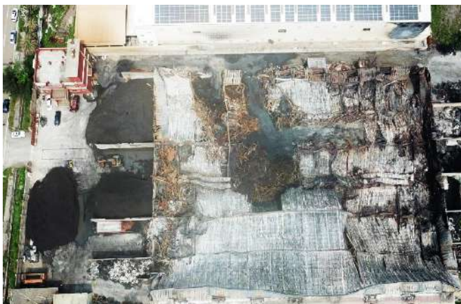
▲圖 8 廠房屋頂燒損情形空拍照
