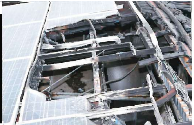
▲圖 7 豬舍 1 屋頂燒損情形
