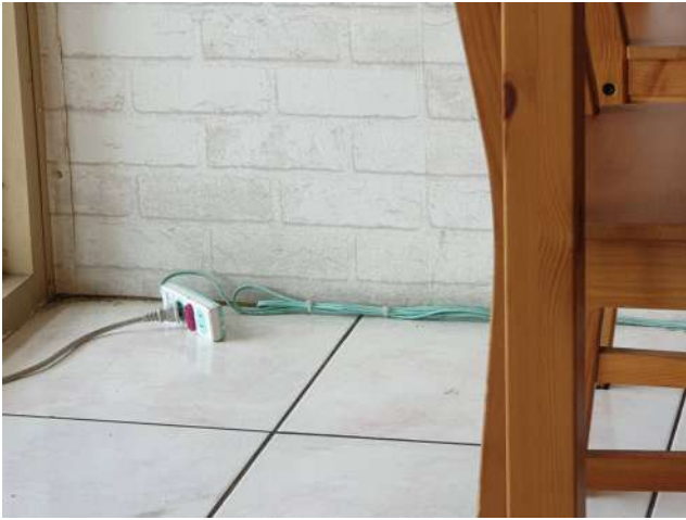
▲延長線不當綑綁容易提高火災風險
