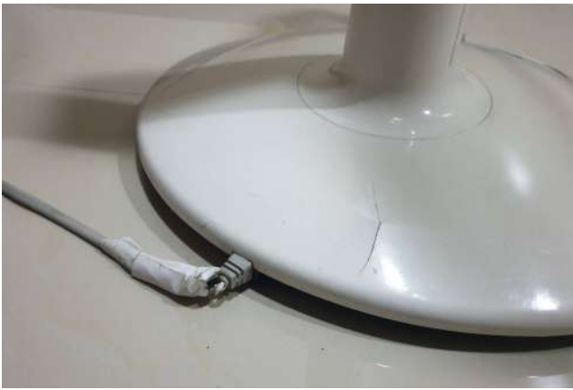
▲電線破損容易造成短路起火
