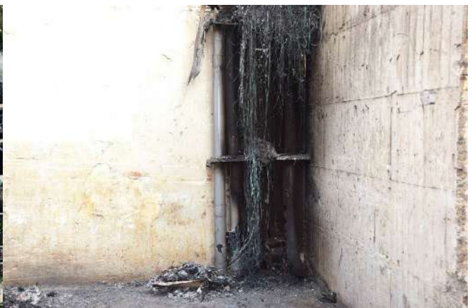
▲圖 9 西側外牆中段太陽能電源線路
