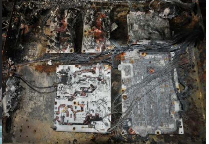
▲圖 11 內部電路板等嚴重燒損
