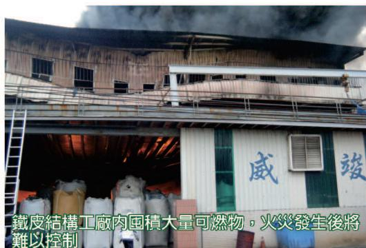
鐵皮結構工廠內囤積大量可燃物，火災發生後將難以控制
